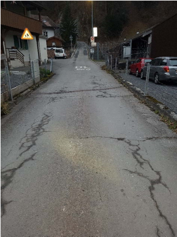
Talweg Bereich «Rossgaden»
