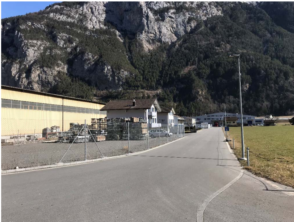
Der sanierte Schlenggenweg
